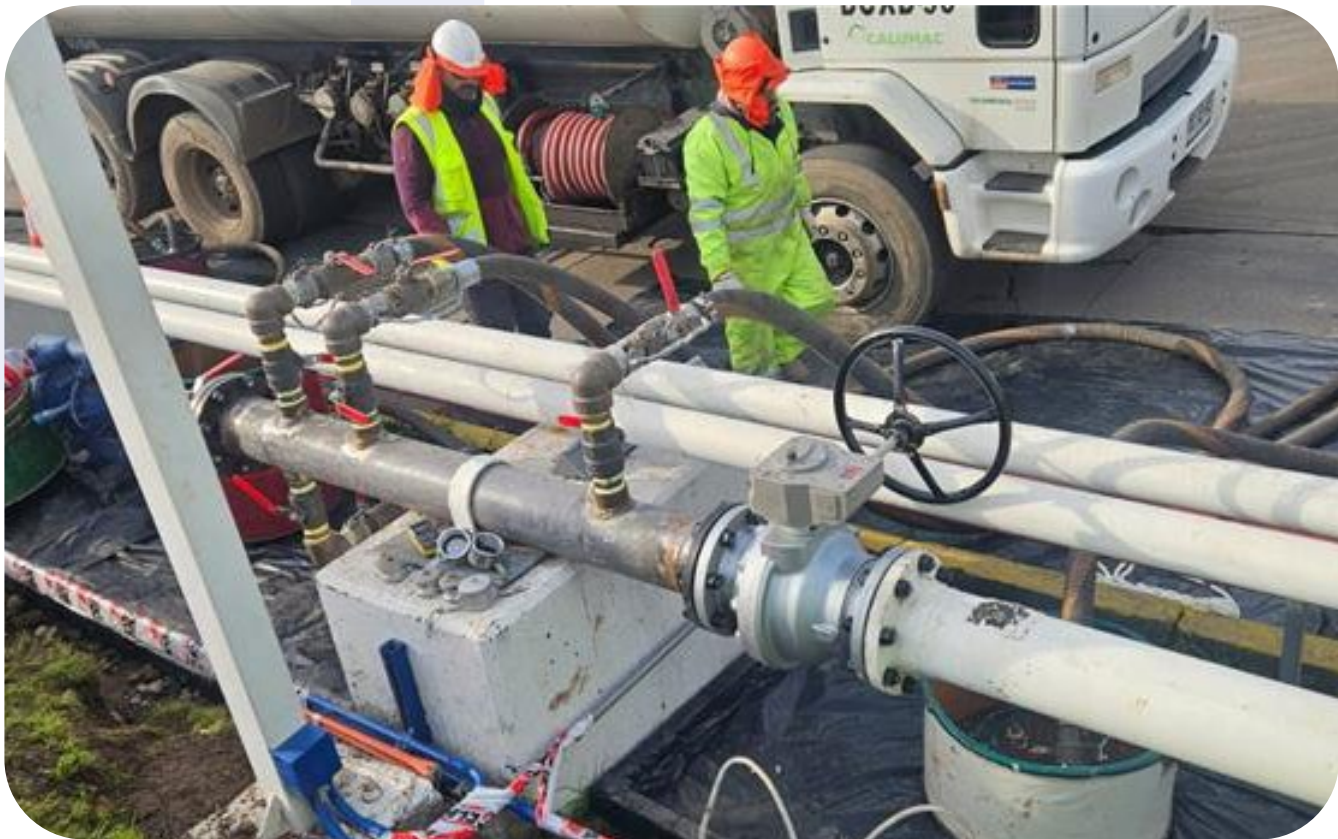
Proyecto Profundización y Protección del oleoducto Maipú - Aeropuerto AMB por Tren Melipilla - Estación Central.
